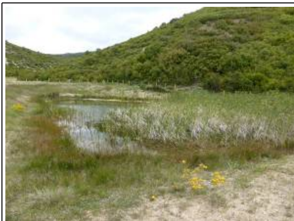
Balsa de PVC en Berroya. En este caso se está produciendo una naturalización de la infraestructura
