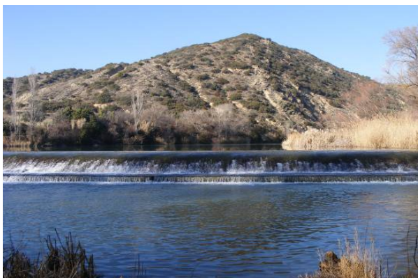
Azud infranqueable para los peces de la minicentral de Sangüesa I.
