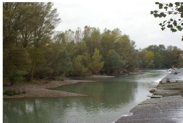
Azud infranqueable para los peces de la minicentral de Cáseda I.
